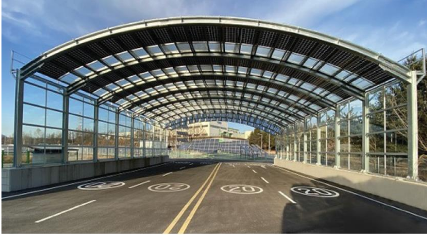
현대에너지솔루션 충북 음성공장 내 방음터널용 양면태양광 솔루션이 적용된 방음터널 (현대에너지솔루션제공)©
